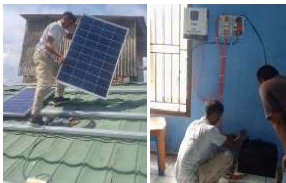
Gambar 5. Pemasangan panel surya di atap kantor Kepala Desa Mbawi
